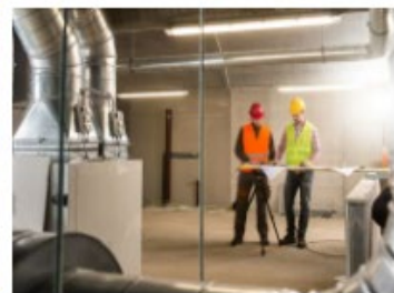
INSINÖÖRI (AMK), TALOTEKNIikka
